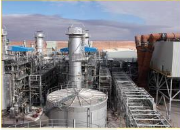
إنشاء محطات للكهرباء في اليمن
