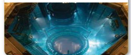
الشكل 12 يُعبر قلب المفاعل الذي يشتمل على حزم قضبان الوقود في حجرة تبريد.
