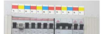
الشكل يمثل : قاطع الوظيفة : الحماية من التيار الزائد
